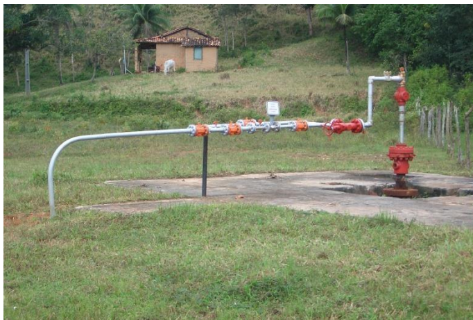
Imagem 4 - Poço de Injeção de Água no Campo de Gomo
